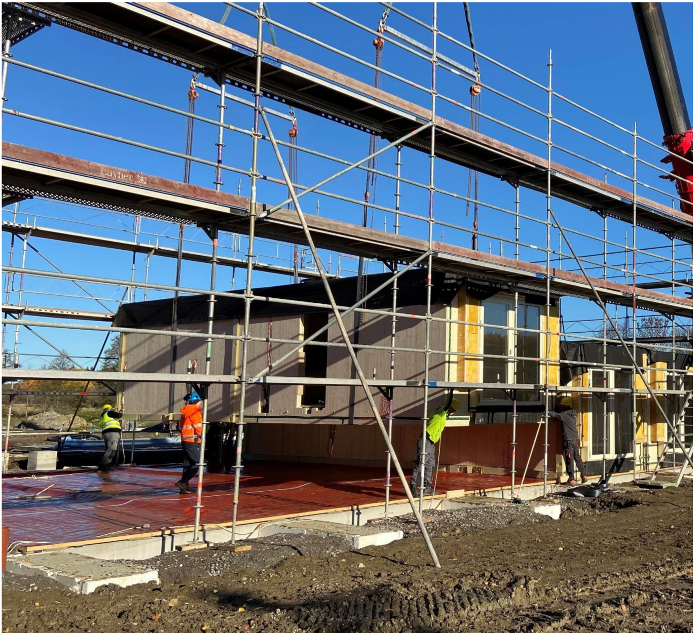
Moduler som ska bli hyreshus lyfts på plats i Sörfjärden.
